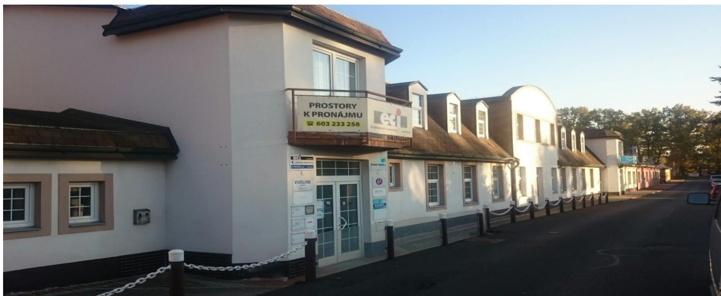
VSTUP DO LEVÉ ČÁSTI OBJEKTU PRONÁJMŮ
