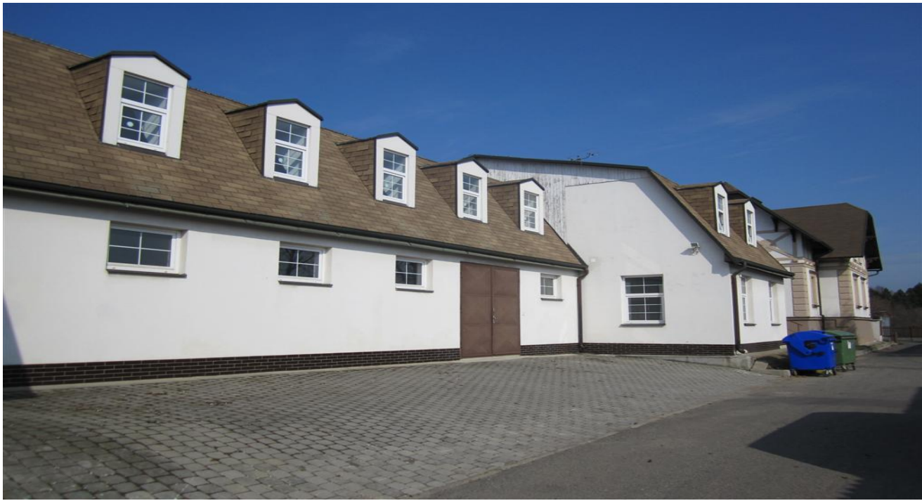
ZADNÍ ČÁST OBJEKTU - SMĚR SEVER
