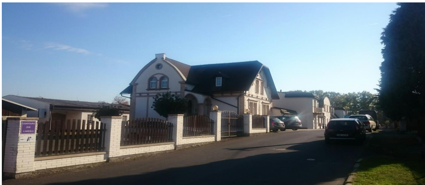
FIREMNÍ OBJEKTY POHLEDEM Z ULICE [ PARKOVIŠTĚ - VILA - OBJ.PRONÁJMŮ ]
