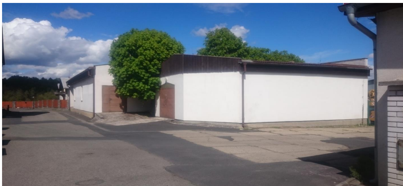
Skladová hala 64 m 2
