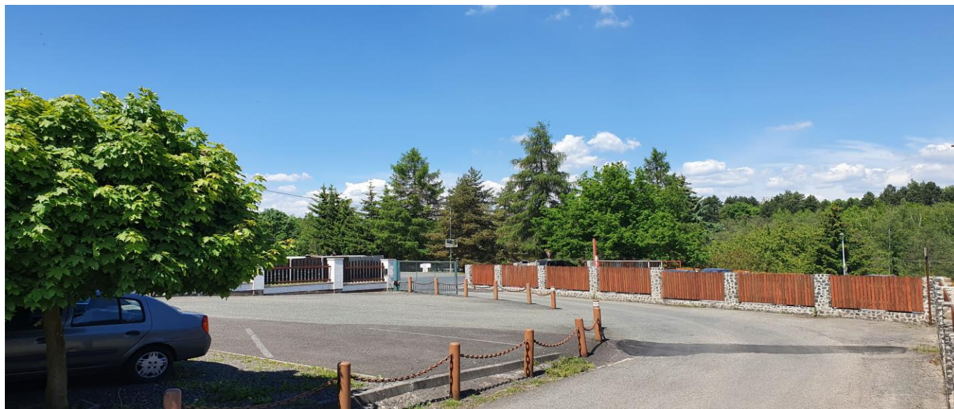
Vjezd do areálu ke skladové hale
