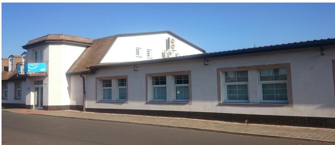
VSTUP DO PRAVÉ ČÁSTI OBJEKTU
