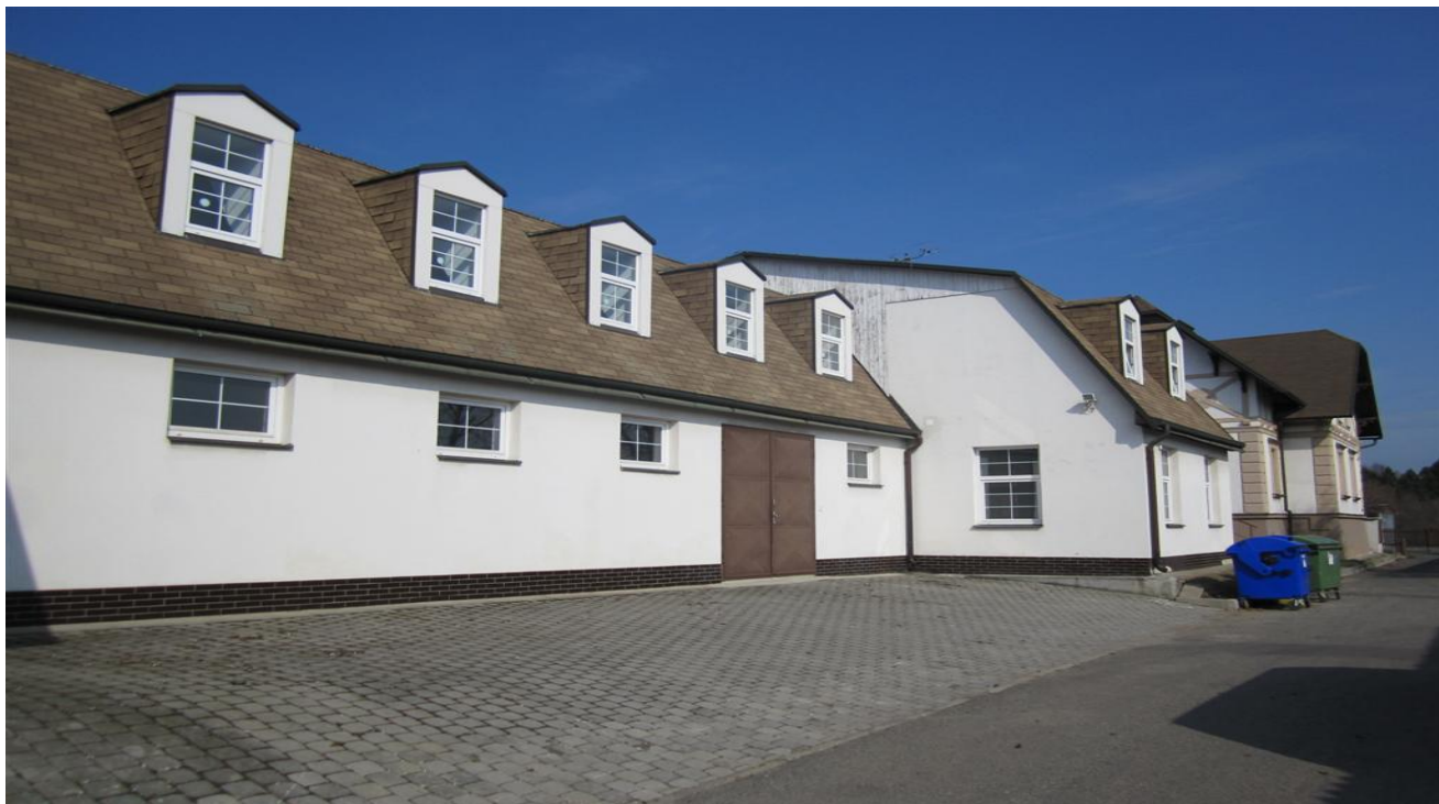
ZADNÍ ČÁST OBJEKTU - SMĚR SEVER
