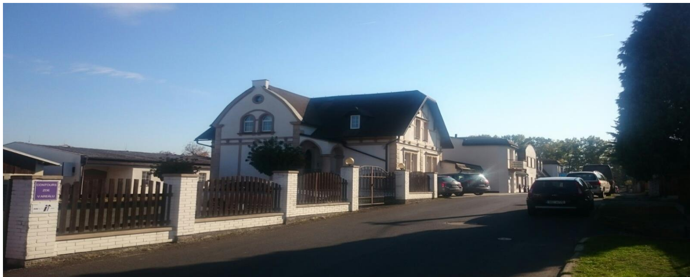
FIREMNÍ OBJEKTY POHLEDEM Z ULICE [ PARKOVIŠTĚ - VILA - OBJ.PRONÁJMŮ ]
