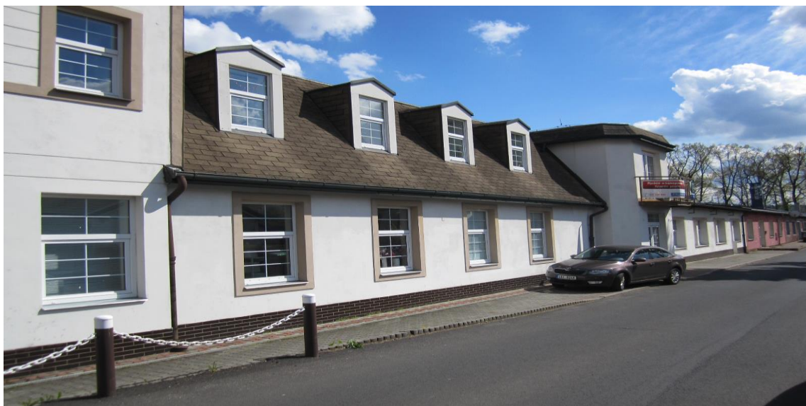
VSTUP DO PRAVÉ ČÁSTI OBJEKTU K PRONÁJMU 8
